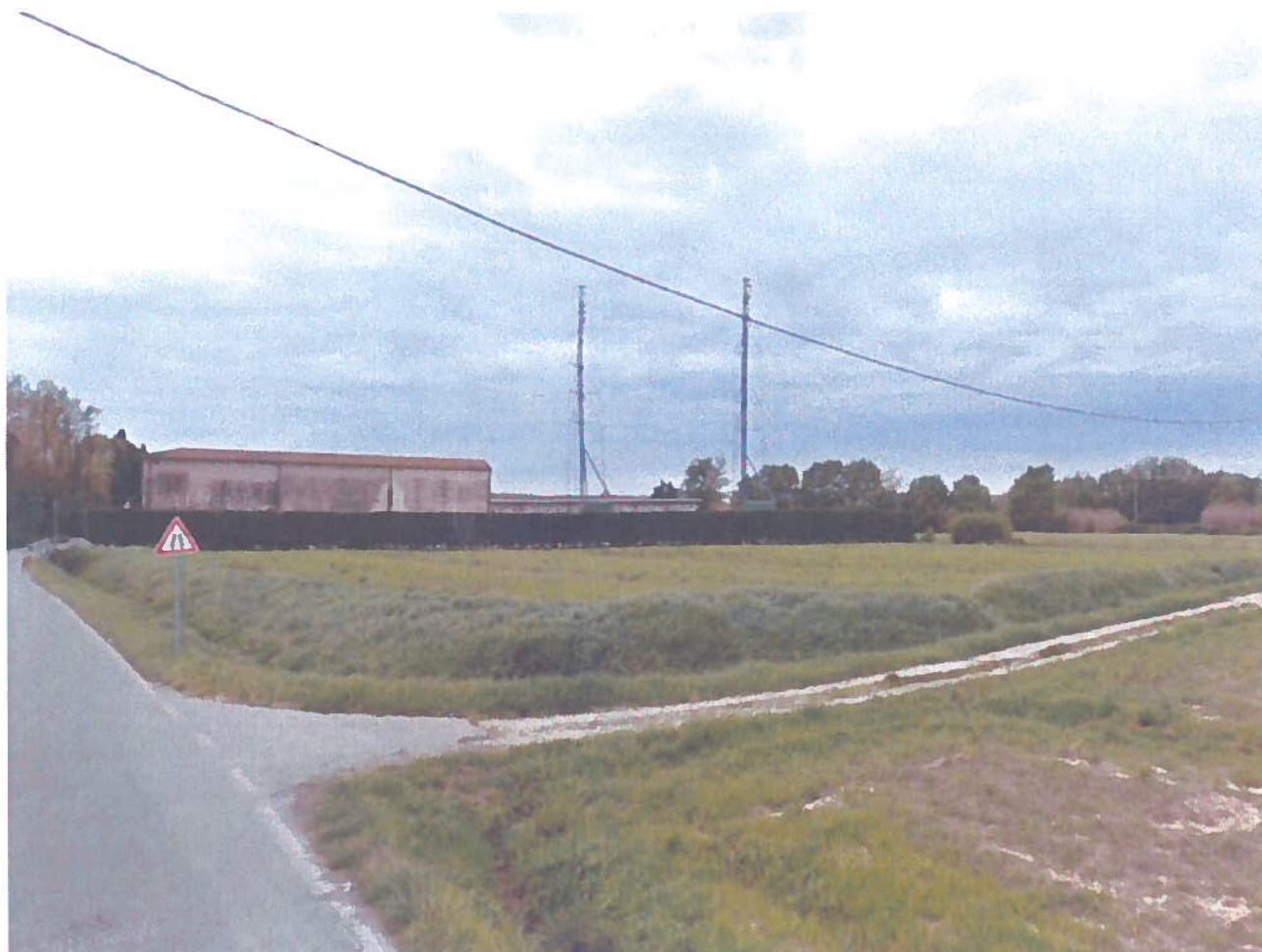
Foto area d'intervento da Via Foscolo.
